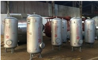
Ресиверы азота объемом 0,9 \text{ м}^3 >
